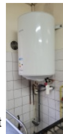
Chauffe-eau de la salle des fêtes trop petit
